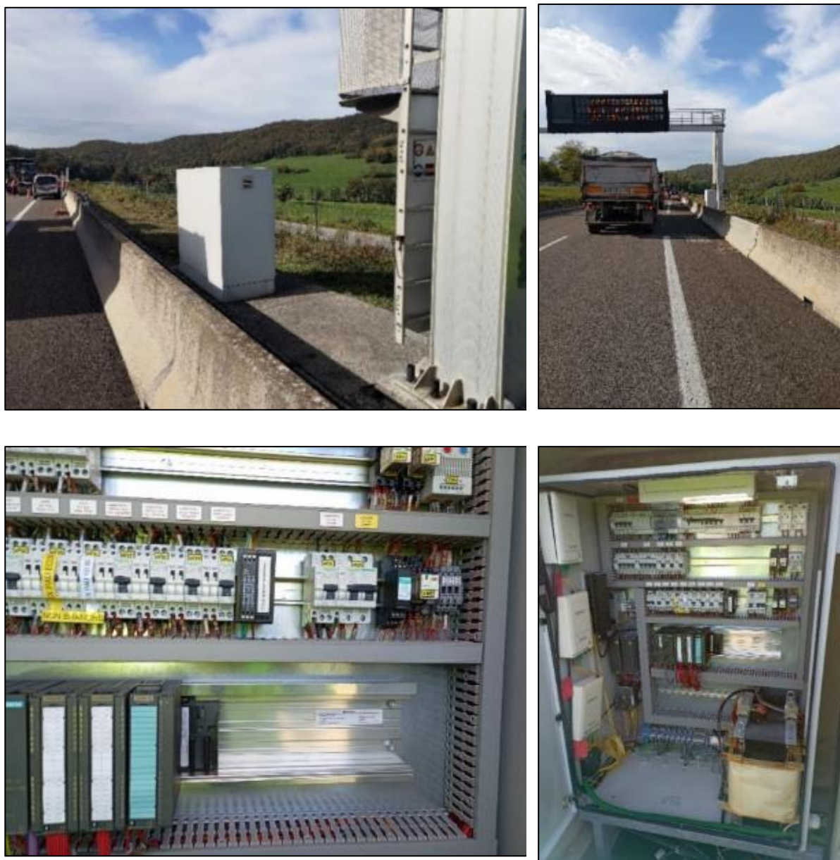
Figure 9 : Armoire Energie Profil 187
